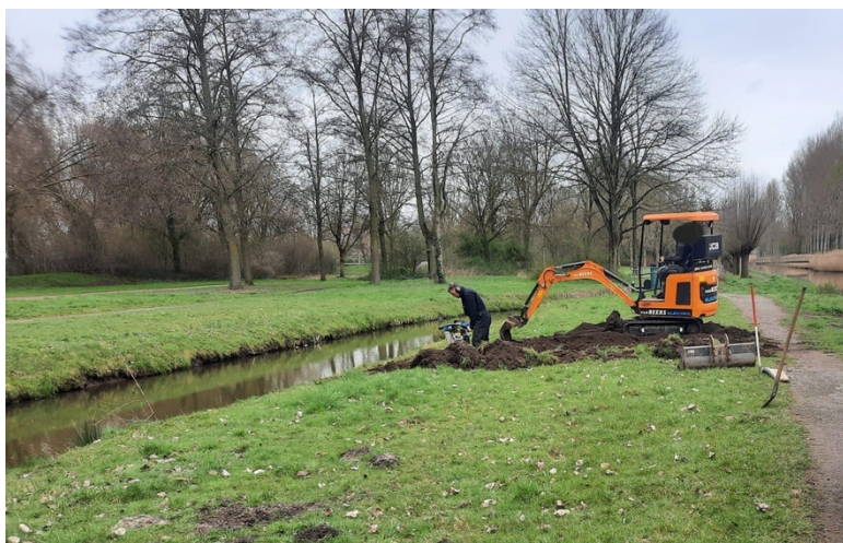
Foto gedurende werkzaamheden
